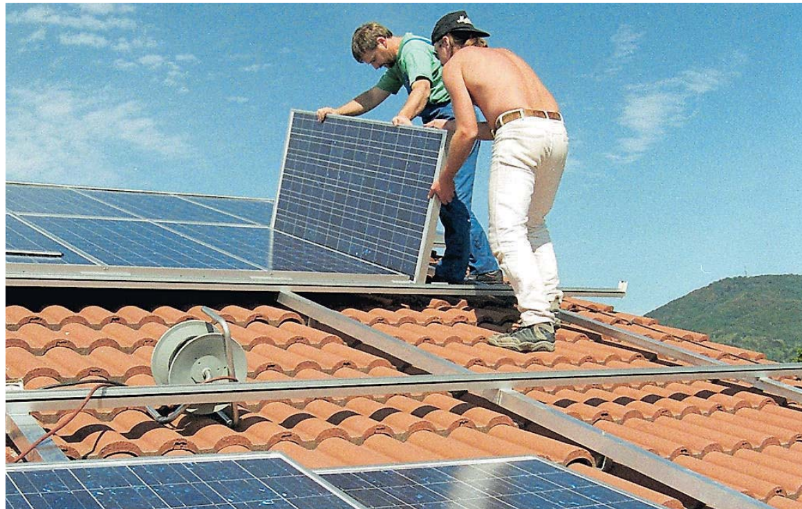
Für die Installation von Photovoltaikanlagen auf Hausdächern gibt es ab sofort eine Prämie. Foto: dpa
